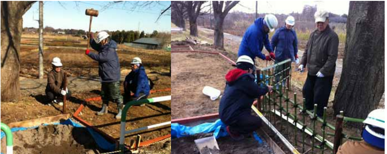
作業写真（今回は真竹を入手できたので、きれいな仕上がりとなりました。）
