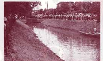
6 閘室内(一の関と二の関の間)の水位が上昇し、二の関を通過できるようになる(実演では船は二の関を通過しません)。
