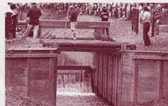
5 一の関に角落板を7枚取り付けられたところ。3の写真と比較すると、水位が上昇していることがわかる(実演開始後、約1時間経過)。
