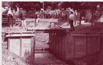
3 一の関に角落板を3枚取り付けられたところ(手前が芝川側)。閘枠より上流部分の水位が徐々に上昇していく。
